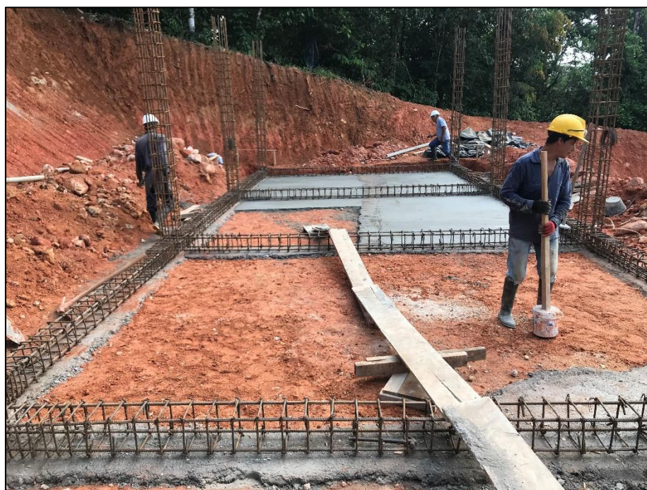
Foto No. 4 – Caseta de operación.
