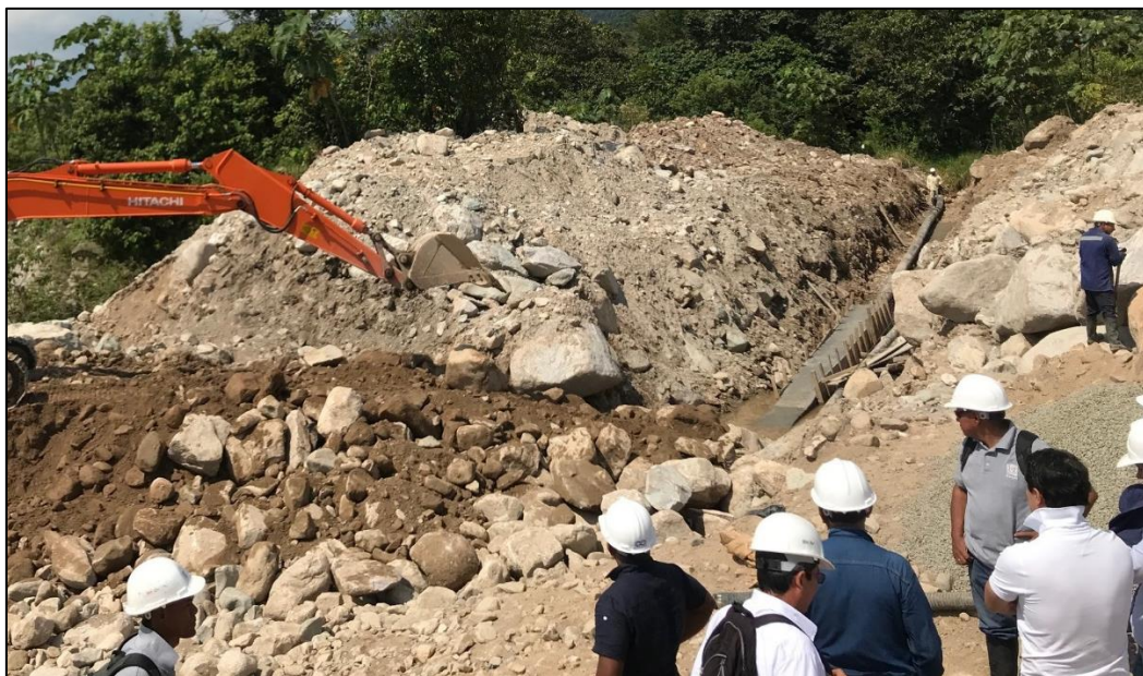
Foto No. 9 – Cruce subfluvial – Quebrada Taruca.
