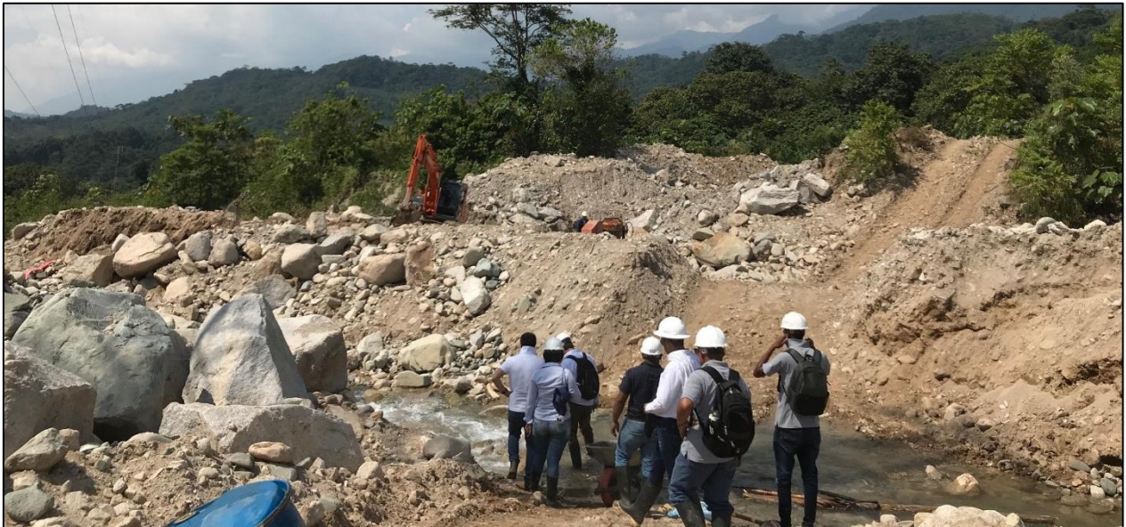
Foto No. 8 – Cruce subfluvial – Quebrada Taruca.
