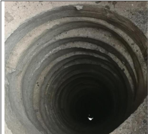
Descripción: Interior pozo excavado protegido con anillos en concreto, al fondo espejo de agua.
