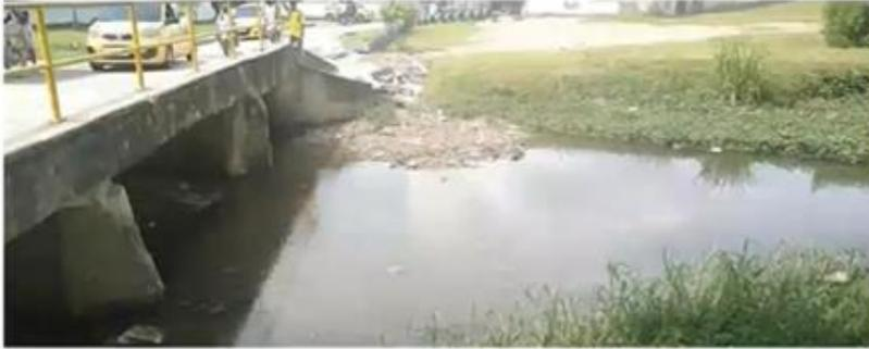
Alcantarilla en cajón de 3 celdas de ancho variable entre 3,90 y 5,70 m y altura de 1,72 m localizada entre las abscisas K2+441,59-K2+447,98 (Frente a Urbanización los Cerezos)
