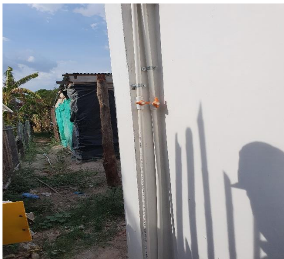
Fecha: 17/02/2021. Instalación de abrazaderas de fijación de tubería al muro.
