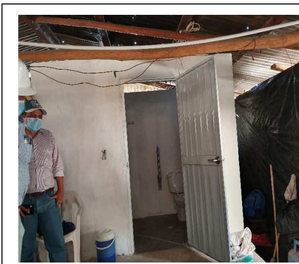
Fecha: 18/02/2021. Construcción caseta tipo 4
