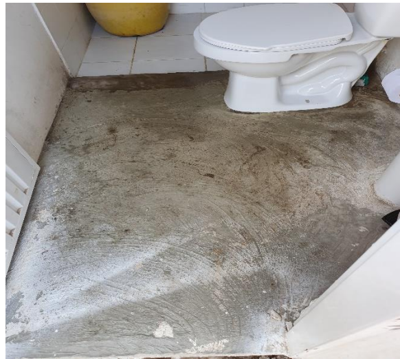
Fecha: 17/02/2021. Acabado de piso, realizado por el propietario del inmueble.
