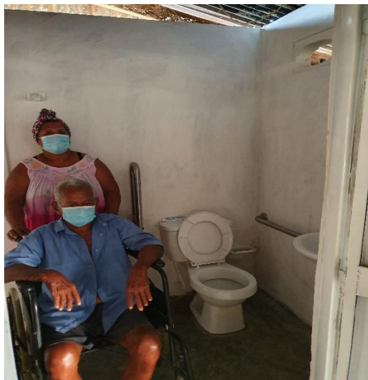
Fecha: 18/02/2021. OBSERVACIÓN: Realizar pintura uniforme en caseta en la parte interior y exterior.
