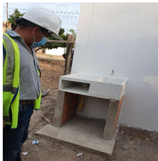
Fecha: 17/02/2021. Construcción de lavadero incluye muretes.
