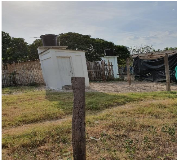
Fecha: 17/02/2021. Unidad sanitaria tipo 3, incluye tanque de almacenamiento.
