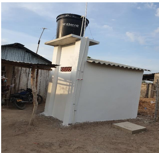
Fecha: 17/02/2021. Construcción caseta tipo 3.
