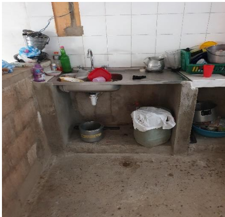
Fecha: 17/02/2021. Instalación de lavaplatos sobre muretes existentes.
