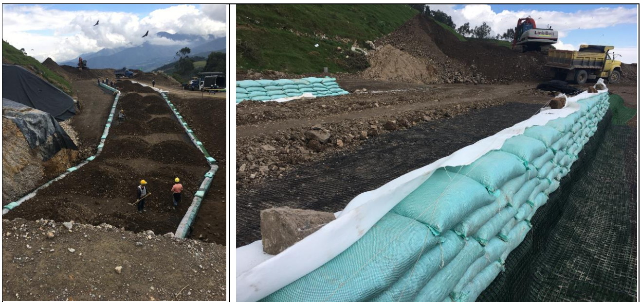
Fotos: Muro de contención en tierra armada reforzada en proceso constructivo - 11-03-2021
