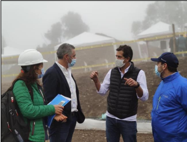
Fotos: Recorrido con el Viceministro por el nuevo vaso de disposición final y el muro de contención en proceso constructivo en el relleno sanitario regional “La Cortada” en Pamplona- 11-03-2021
