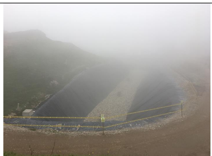
Foto: Nuevo vaso de disposición final en el relleno sanitario regional “La Cortada” en Pamplona- 11-03-2021
