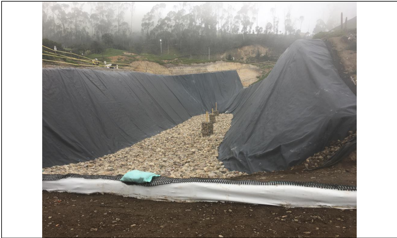
Foto: Nuevo vaso de disposición final en el relleno sanitario regional “La Cortada” en Pamplona- 11-03-2021
