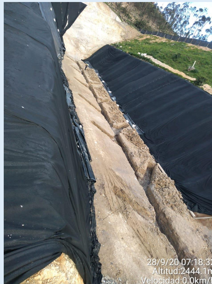
Instalación de geotextil y geomembrana
