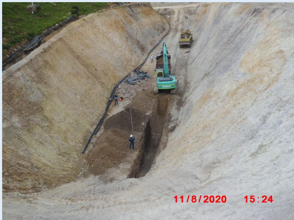
Excavación de filtros para manejo de lixiviados
