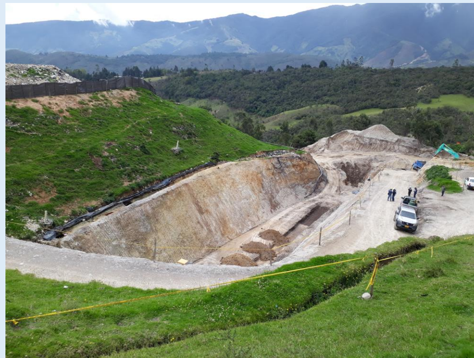
Excavación y adecuación del fondo del nuevo vaso de DF
