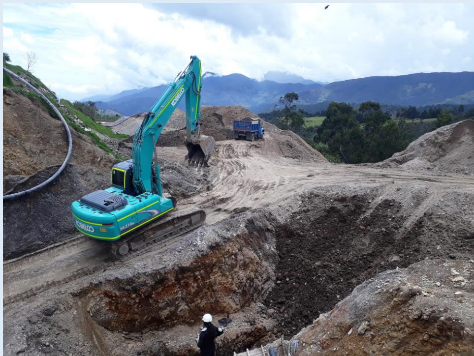
Excavación del nuevo vaso de DF
