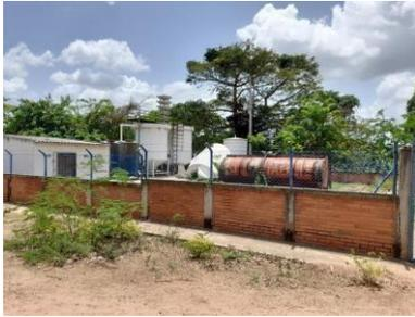
Planta de tratamiento de agua sin funcionar por que no la entregaron a la comunidad y nunca le hicieron mantenimiento, además se derrumbó un tanque el cual lo reemplazaron por un tanque de carro tanque.
