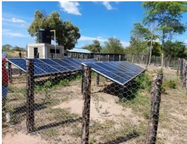
Paneles solares que extraen agua del pozo y la envían a la planta potabilizadora la cual está dañada.
