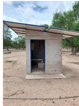
Sistema de extracción de agua del pozo con paneles solares, instalado hace un año y dejó de funcionar en el mes de noviembre, la comunidad dice que el daño es eléctrico.
