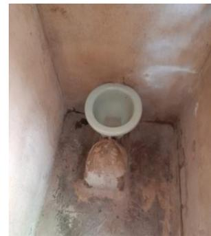
Letrina de losa con descargue manual y pozo séptico.
