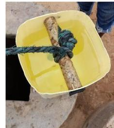
Pozo escavado con extracción de agua manual, sin recubrimiento. El agua del pozo es salobre
