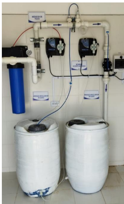
Imagen 5. Sistema de prefloración y cloración
