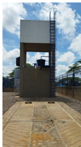
Imagen 6. Rampla de cargue camiones
