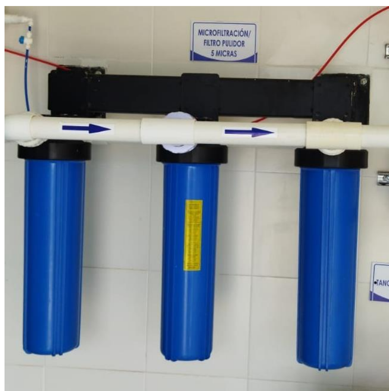
Imagen 4. Microfiltración
