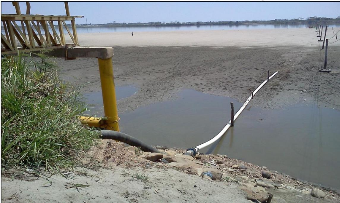
**Imagen 24.** Bocatoma Acueducto de Puerto Giraldo brazo del Río desconectado del cauce principal (enero 2016)
