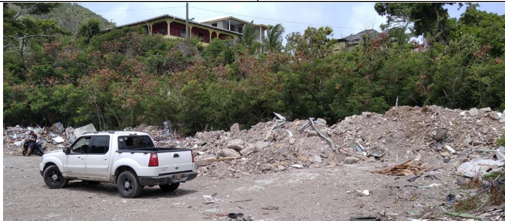
Foto: Acopio temporal en Camp. Residuos de demolición. 09-07-2021
