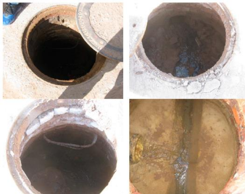
Figura 8. Vista interior pozos de inspección
