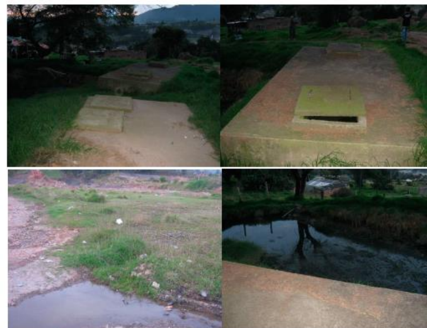
Figura 13. Registro fotográfico tanques sépticos al suroeste de Patio Bonito
