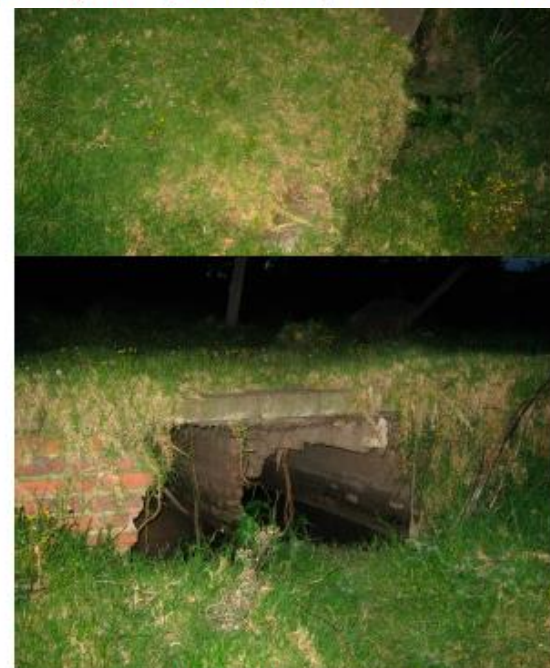
Figura 14. Registro fotográfico tanque séptico al Sureste del centro poblado Patio Bonito
