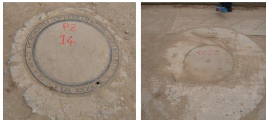
Figura 9. Pozo existente no inspeccionado
