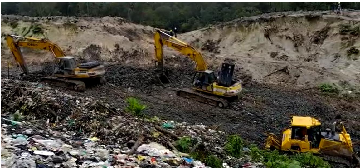
Frente de trabajos – Vaso norte.
