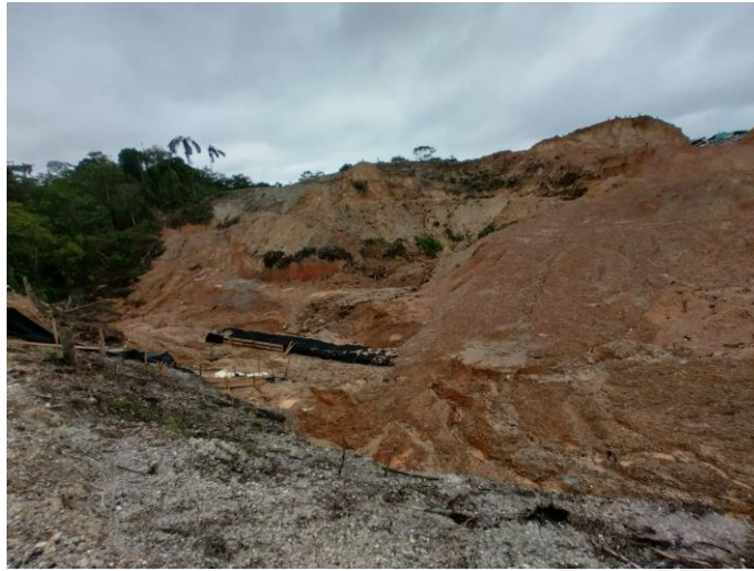
Frente de trabajos. Vaso Sur.
