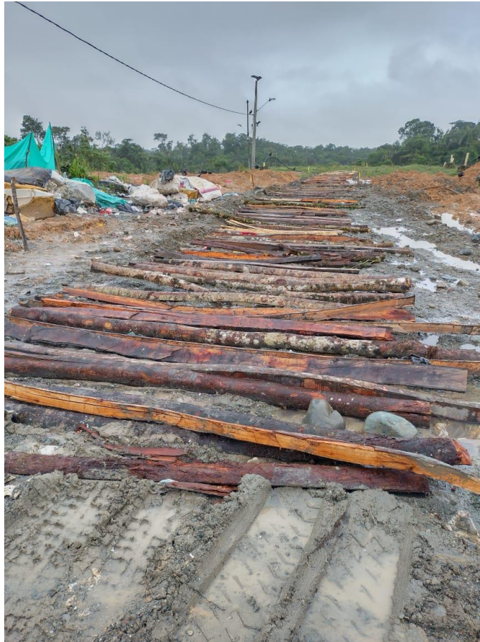
Vía de acceso constructiva, acceso zonas de disposición.
