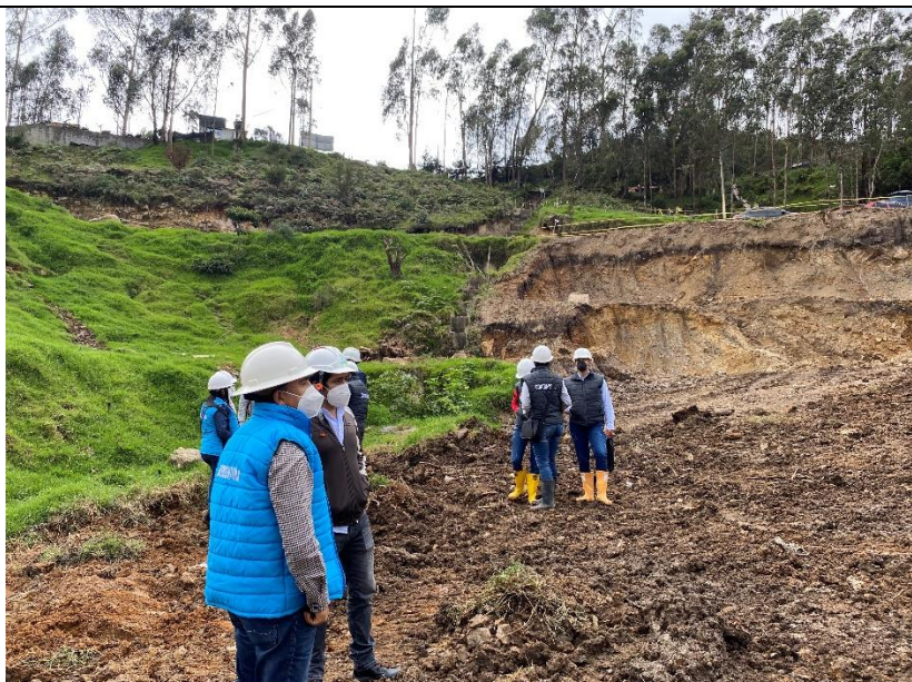
Fotografía 7. Al fondo perfil estratigráfico de la excavación extremo nor-occidental del vaso norte de disposición final.
