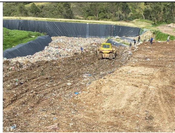
Fotografía 4. Frente de disposición actual en el vaso sur del relleno sanitario "La Cortada" de Pamplona.
