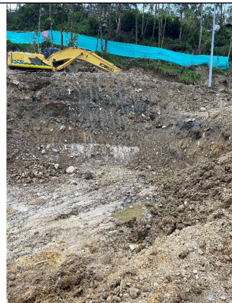
Fotografía 6. Excavación con maquinaria extremo nor-occidental del vaso norte de disposición final.
