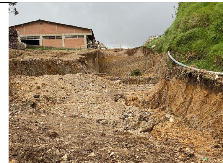
Fotografía 8. Detalle de la excavación para la construcción del muro de contención en tierra armada en su extremo nororiental de vaso nuevo a construir.
