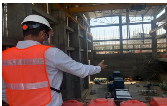
Fecha: 23/03/2022. Visita de obra subproyecto 1 en el municipio de Cúcuta.
