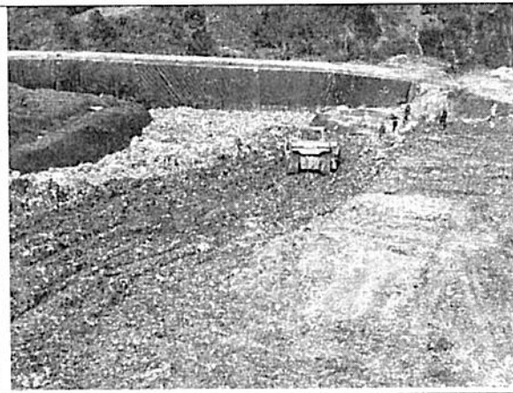
Fotografía 4. Frente de disposición actual en el vaso sur del relleno sanitario "La Cortada" de Pamplona.
