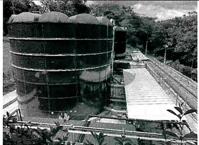
Fotografía 13. Sistema secundario de la planta de tratamiento de Lixiviados. 24-5-2022
