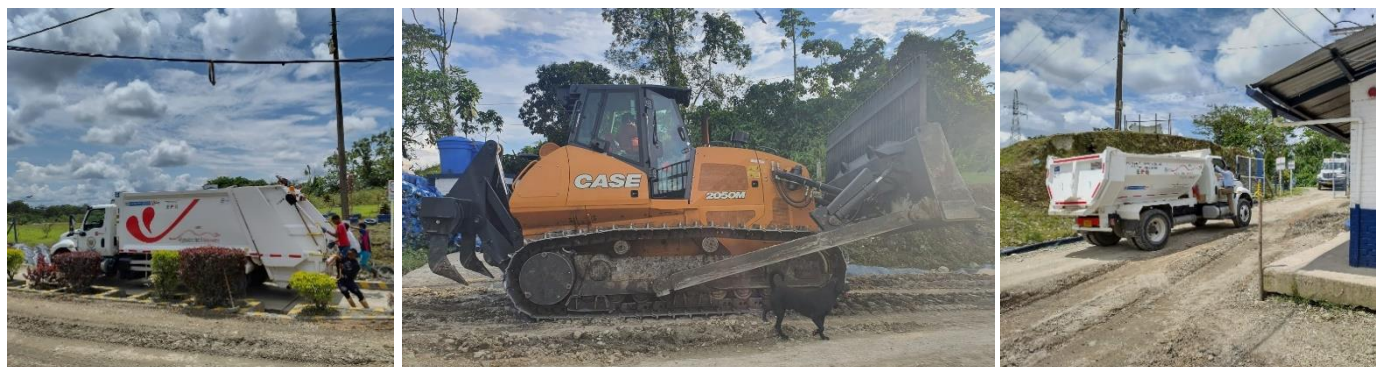
Izq. Vehículo de 14 yd3, centro: buldócer y derecha: volqueta. 22-06-2022.
