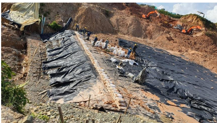
FOTO 4: Base del muro en gavión y construcción de muro en tierra
