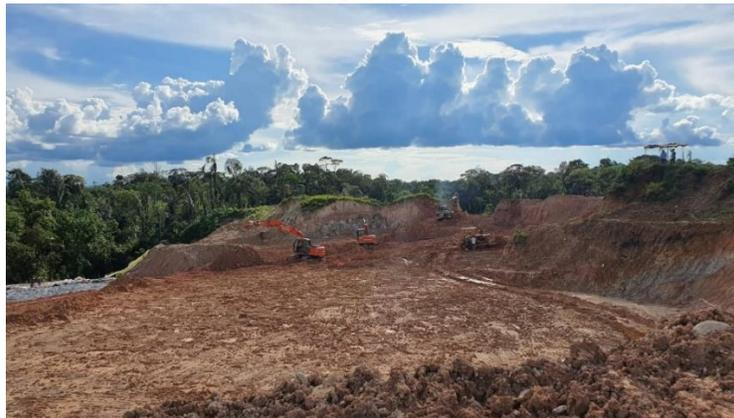
Vaso norte: en nivel base (cota 46) listo para iniciar instalación de geomembrana. Este vaso fue necesario recortarlo puesto que se requería un área para que EPQ pudiera contar con un área para disponer residuos con vida útil hasta septiembre de 2022. El área que se pierde se gana en altura puesto que está autorizado el llenado hasta la cota máxima 67. El talud tiene residuos por ambas caras por lo que no va a tener que soportar carga de residuos, se construye con especificaciones.
