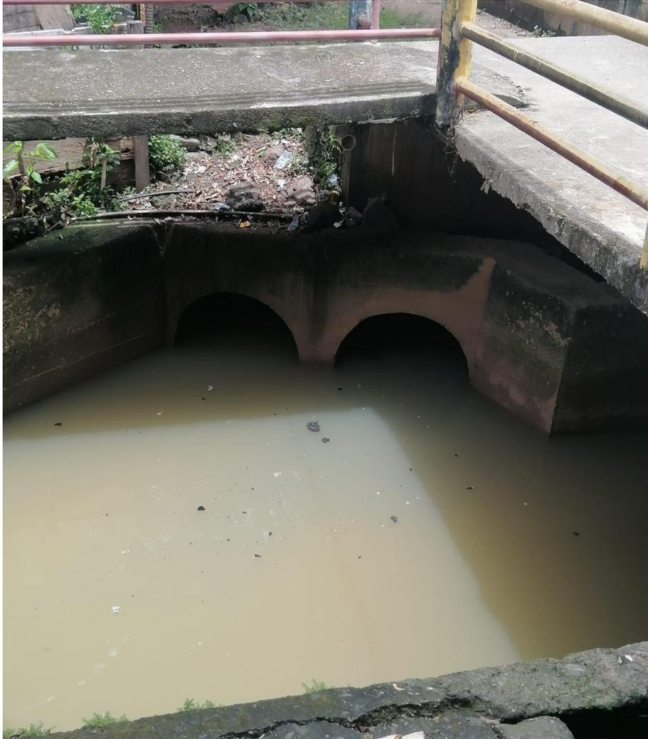
Foto 7. Imagen del estado del descole actual del sistema, al que verterán las aguas residuales y de aguas lluvias de las tuberías proyectadas. Esta estructura puntual se localiza a 500 metros de la ribera del río Cauca.
