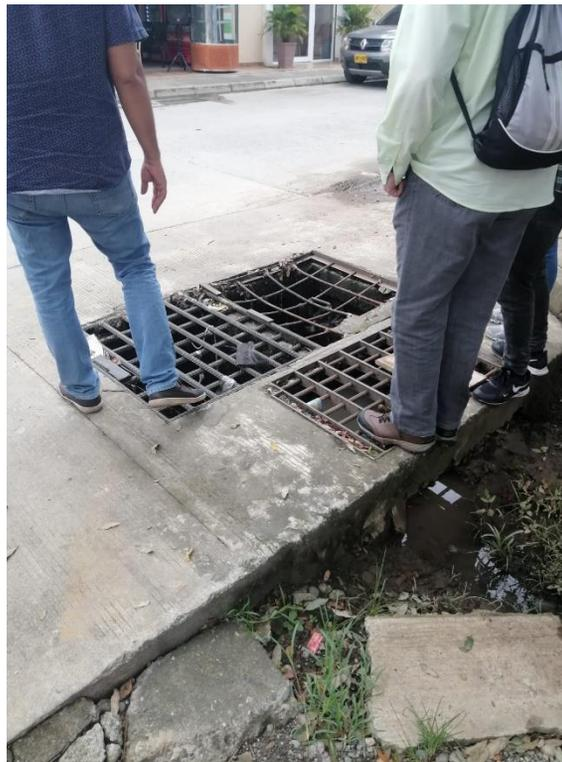
Foto 2. Aspecto promedio del estado de los sumideros y colectores del sistema de alcantarillado combinado que se pretende separar.
