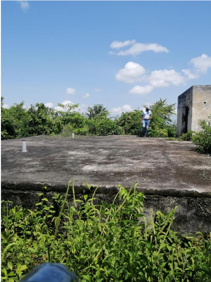
Estructura del tanque de almacenamiento existente y que se encuentra fuera de servicio. Ese tanque junto con otras estructuras deberá ser demolidas para localizar en esta área las nuevas estructuras del sistema (PTAP y almacenamiento)
