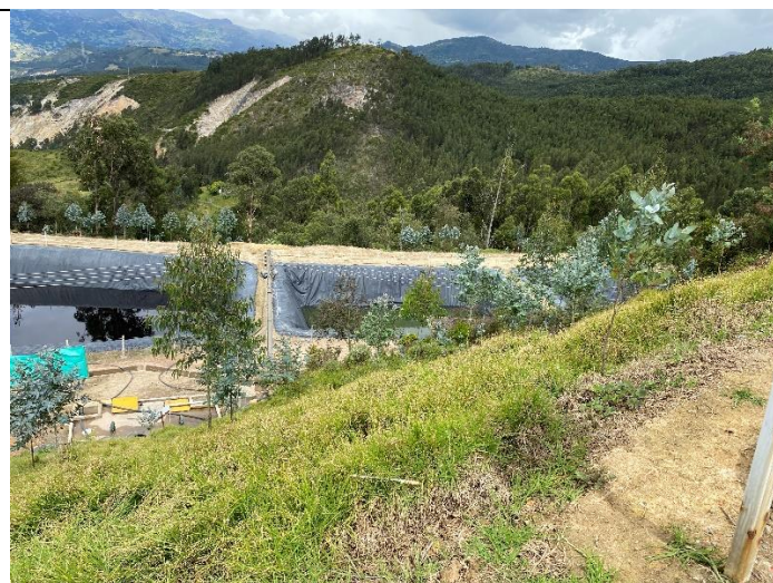
Fotografía 8. Pondajes de almacenamiento de lixiviados.
