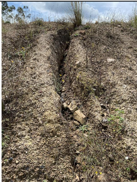
Fotografía 9. Detalle de la formación de surco en el talud del zodme actual.
