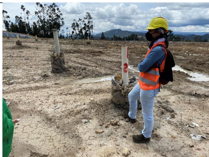
Fotografía 7. Pozo de monitoreo de presión de poros - piezómetro
