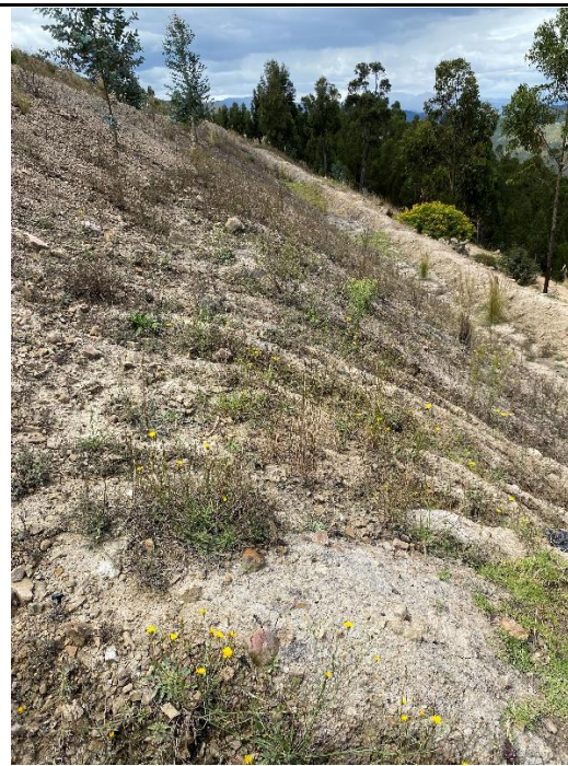
Fotografía 10. Detalle del proceso erosivo (formación de surcos) en talud del zodme actual.
