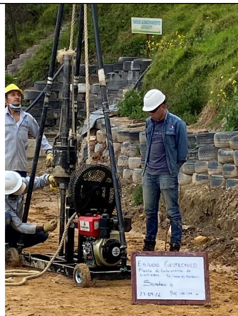
Fotografía 12. Prueba SPT para caracterización del suelo en zona de adecuación de la planta de tratamiento de lixiviados.
