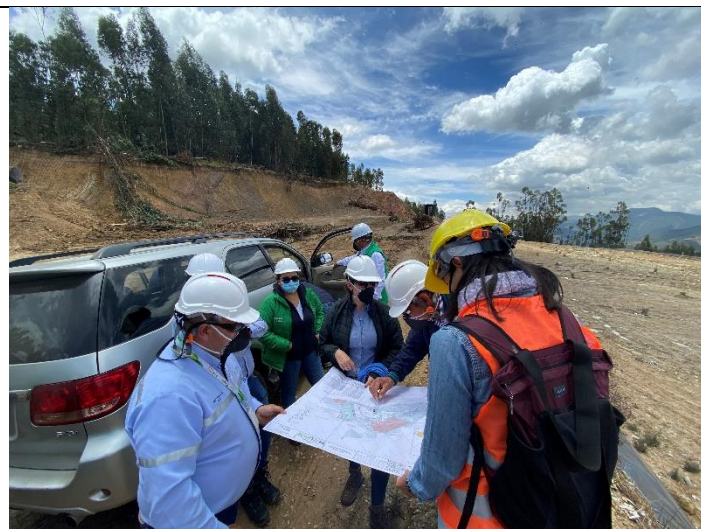
Fotografía 4. Verificación de puntos de control en plano de diseño de terraza D del proyecto.
