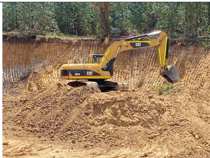
Fotografía 3. Excavaciones en área donde se contempla la terraza D. Se evidencia material arcilloso de la formación Guaduas.
