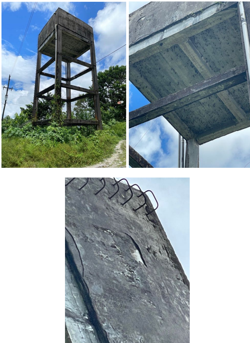
(Fotos tanque de almacenamiento existente – 18/10/2022)
