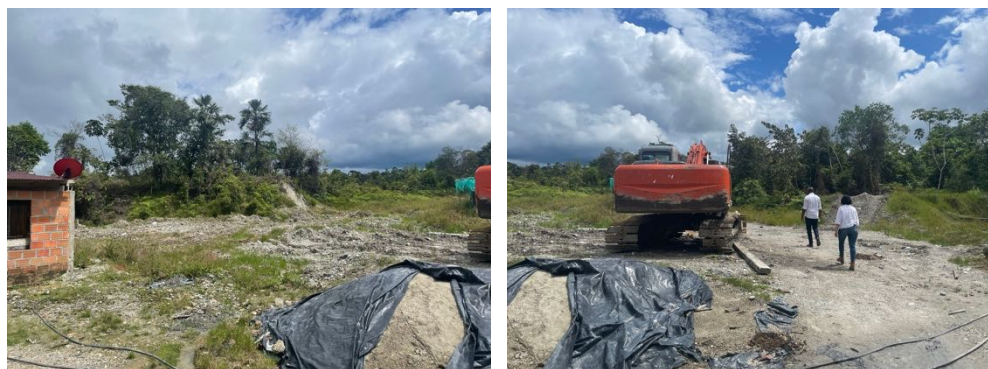
(Fotos predio PTAP existente – 18/10/2022)
