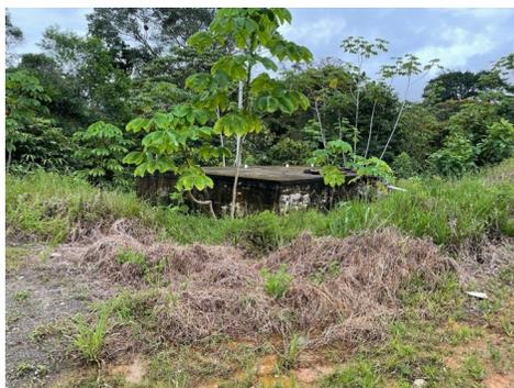
(Foto tanque almacenamiento subterráneo en deterioro- 20/10/2022)
