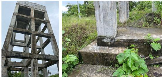
(Fotos Tanque elevado en deterioro, dados de cimentación expuestos y en abandono– 20/10/2022)
