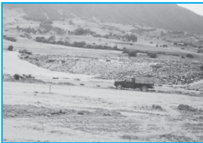
OPERACIÓN DE RELLENO SANITARIO
