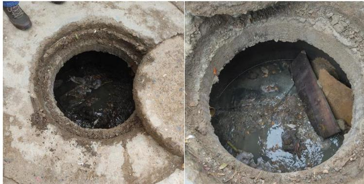
Sedimentos y residuos sólidos identificados al interior de las redes de alcantarillado del sector de La Cancha
