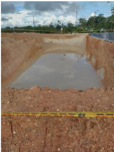
Foto 3. Laguna de tratamiento de lixiviados (en proceso de excavación)
