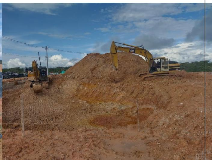
Foto 7. Laguna en proceso de excavación
