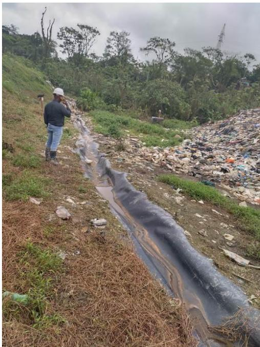
Foto 1. Cunetas perimetrales a la zona de cierre y clausura que colinda con zona utilizada por el operador para disposición final dispersa.
