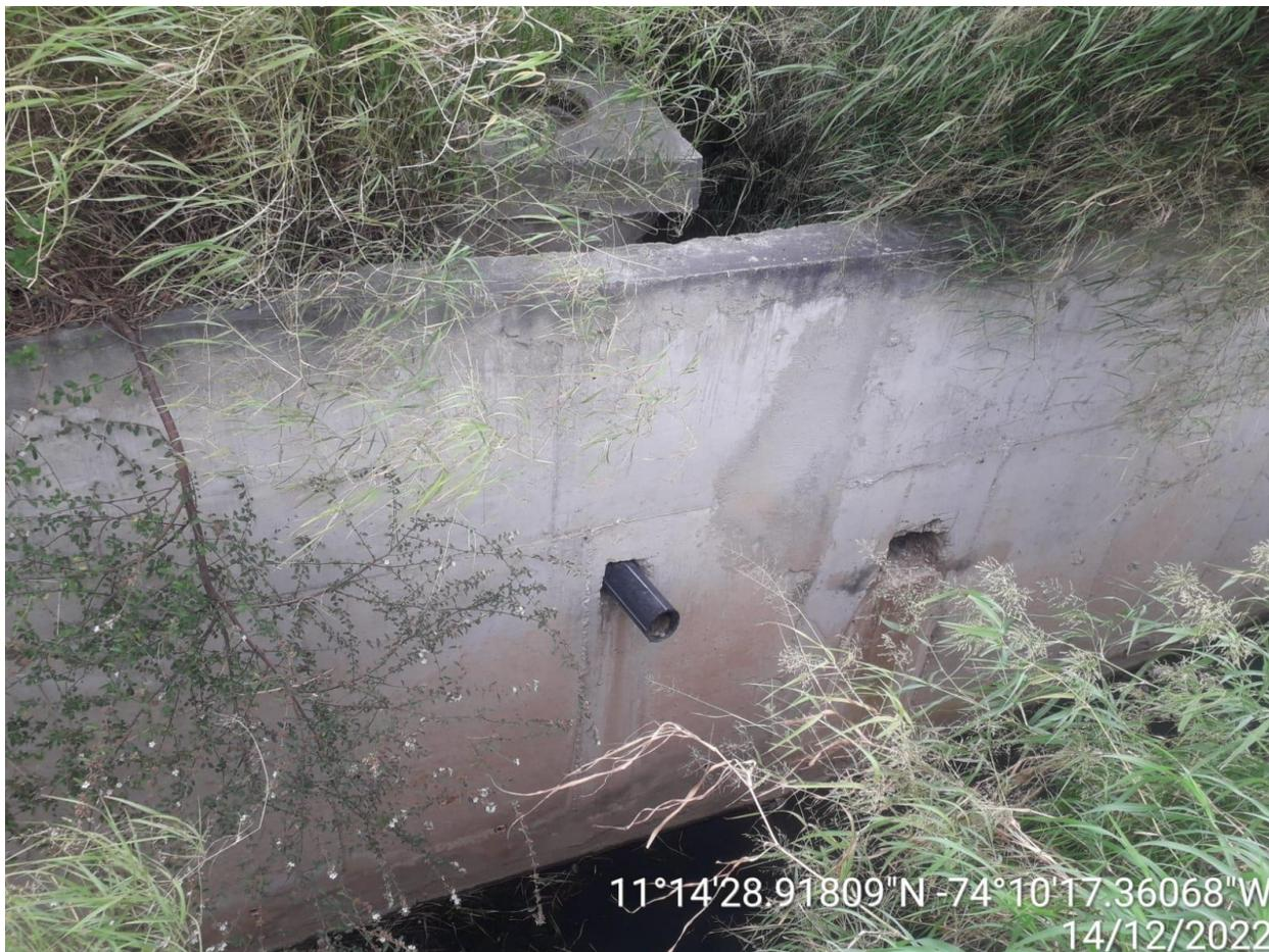
Foto 1. Punto de vertimiento sector El Pantano, junto al pozo de inspección, se evidenció din vertimiento.
