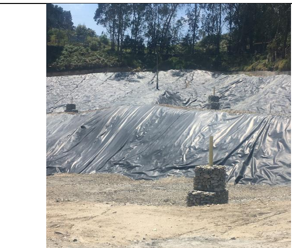
Fotografías 3 y 4. Detalle de geomembrana, chimenea y capa de mezcla de relleno para protección de geomembrana. Fuente: MVCT 23-2-2023
