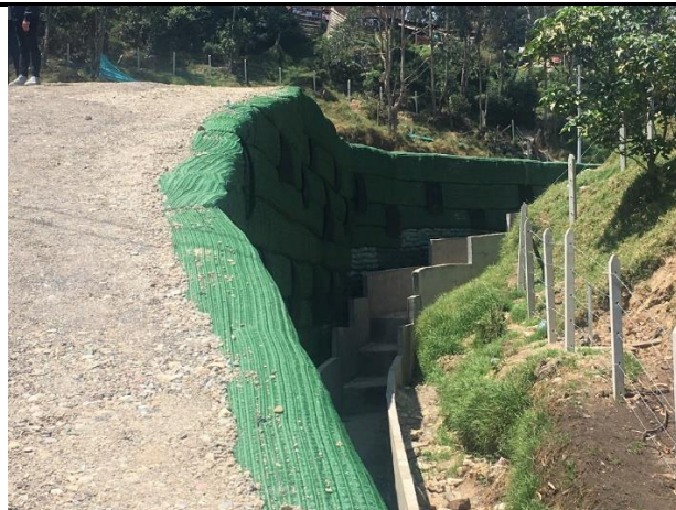
Fotografía 14. Secciones 10 a la 17 del muro de contención terminado. Fuente: MVCT 23-2-2023.
