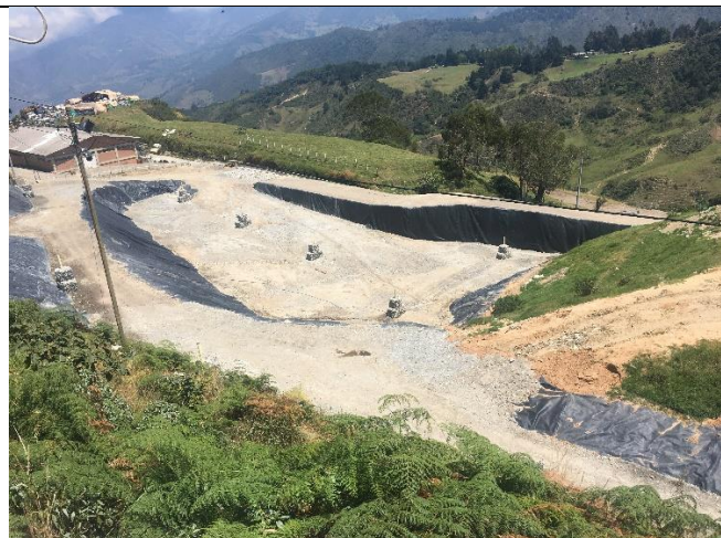
Fotografía 1. Panorámica de la construcción del vaso norte y del muro de contención en tierra armada del proyecto de optimización del relleno sanitario "La Cortada" en Pamplona, Fase II. MVCT 23-2-2023
