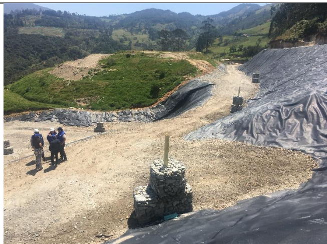
Fotografía 2. Panorámica de la parte alta del vaso norte conformada para la disposición de residuos sólidos y el remonte o domo de disposición. Fuente: MVCT 23-2-2023
