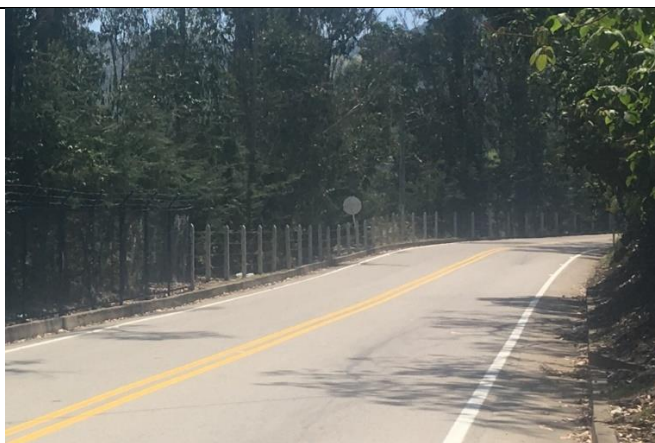
Fotografía 16. Detalle de cerramiento en postes de concreto y alambre de púa. Fuente: MVCT 23-2-2023.
