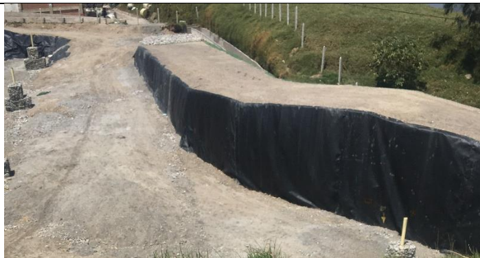
Fotografía 12. Muro de contención del vaso norte terminado según diseño. Fuente: MVCT 23-2-2023.
