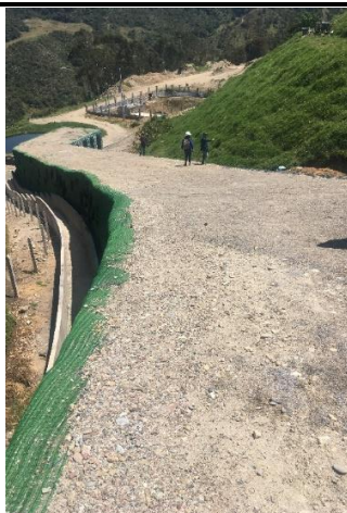
Fotografía 13. Secciones 10 a la 17 del muro de contención terminado. Fuente: MVCT 23-2-2023.
