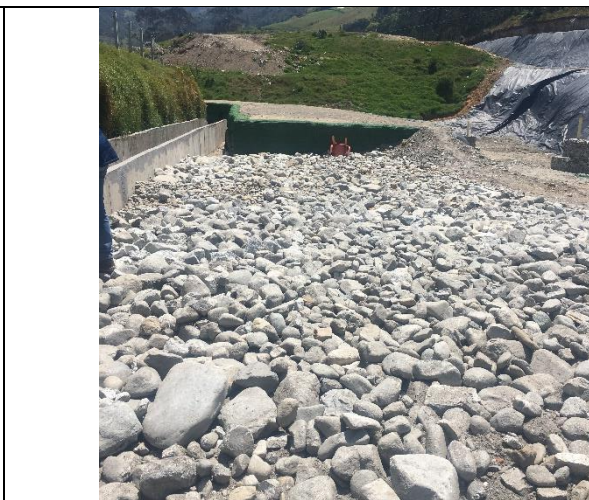
Fotografías 3 y 4. Detalle de geomembrana, chimenea y capa de mezcla de relleno para protección de geomembrana. Fuente: MVCT 23-2-2023
