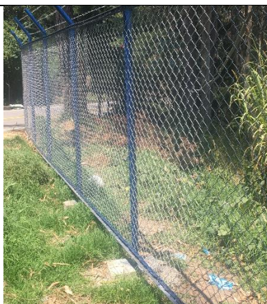
Fotografía 15. Detalle de cerramiento en malla eslabonada y tubo galvanizado. Fuente: MVCT 23-2-2023.
