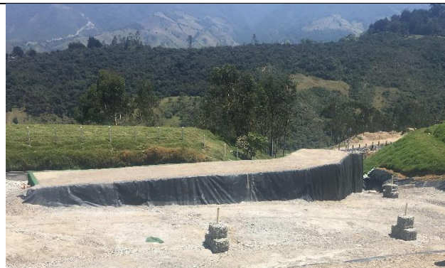
Fotografía 11. Muro de contención del vaso norte terminado según diseño. Fuente: MVCT 23-2-2023.
