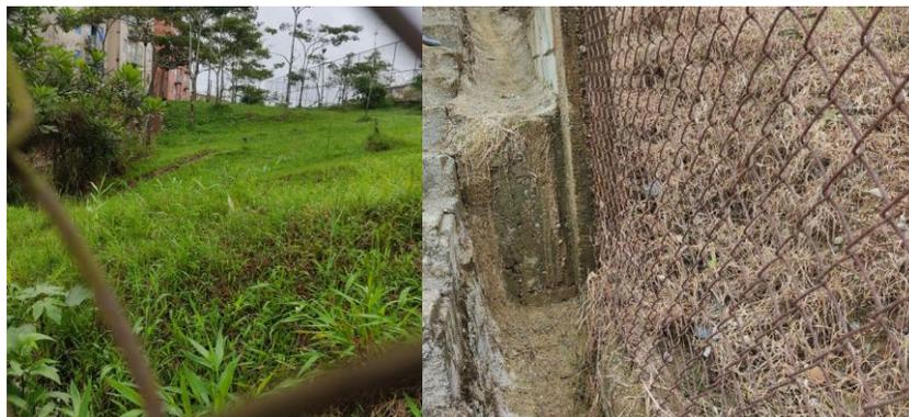
Cunetas y canales externos cubiertos de sedimentos y vegetación, que permiten el ingreso de escorrentía a la PTAR
