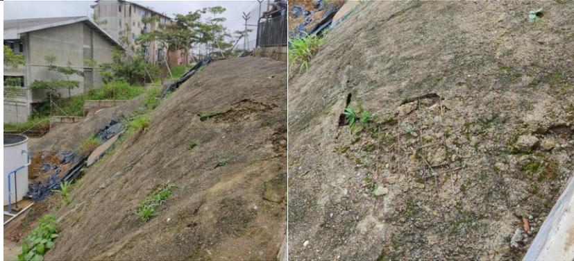
Recubrimiento de talud sin drenaje subsuperficial y áreas deterioradas
