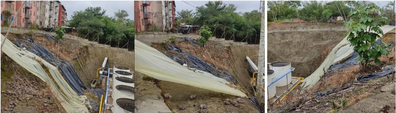
Talud afectado por movimiento en masa en la PTAR del sector A de la ciudadela MIA
