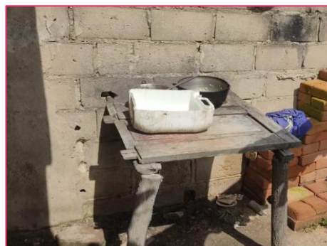
Ausencia de lavaplatos
