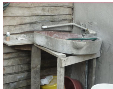
Ausencia de lavamanos
