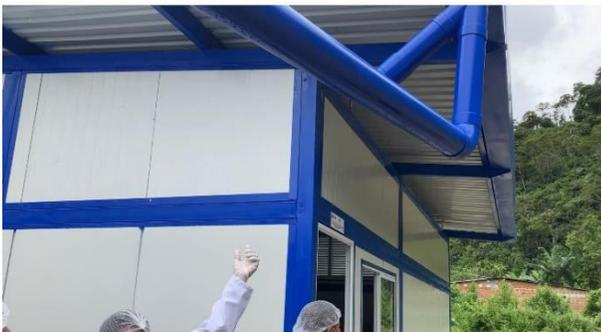
Del techo escurre el agua lluvia y ésta es recolectada a través de la canaleta perimetral instalada como se aprecia en la foto, en la esquina al final de la cota de desagüe, se instalaron tuberías de conducción del agua lluvia a el tanque de almacenamiento, se le instaló una derivación con un tapón el cual se quita para mantenimiento y limpieza de la canaleta.
