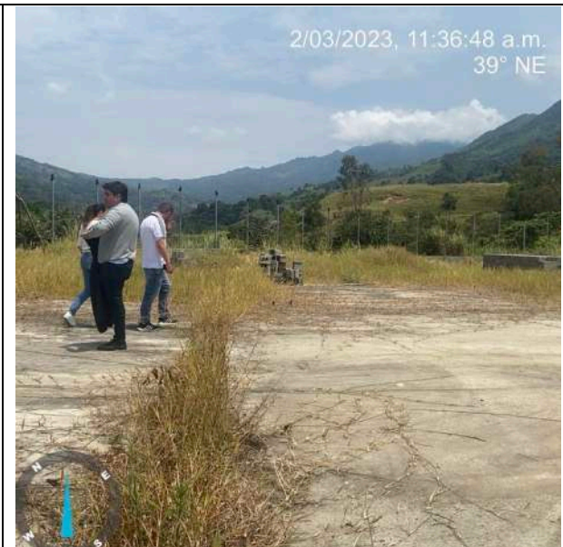
Construcción de placa para ubicación de quipos de la planta
