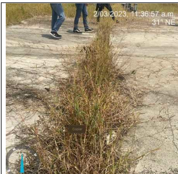
Construcción de canal en tierra para evacuación de lixiviados
