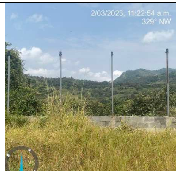
Levantamiento de estructura para cierre perimetral en malla eslabonada
