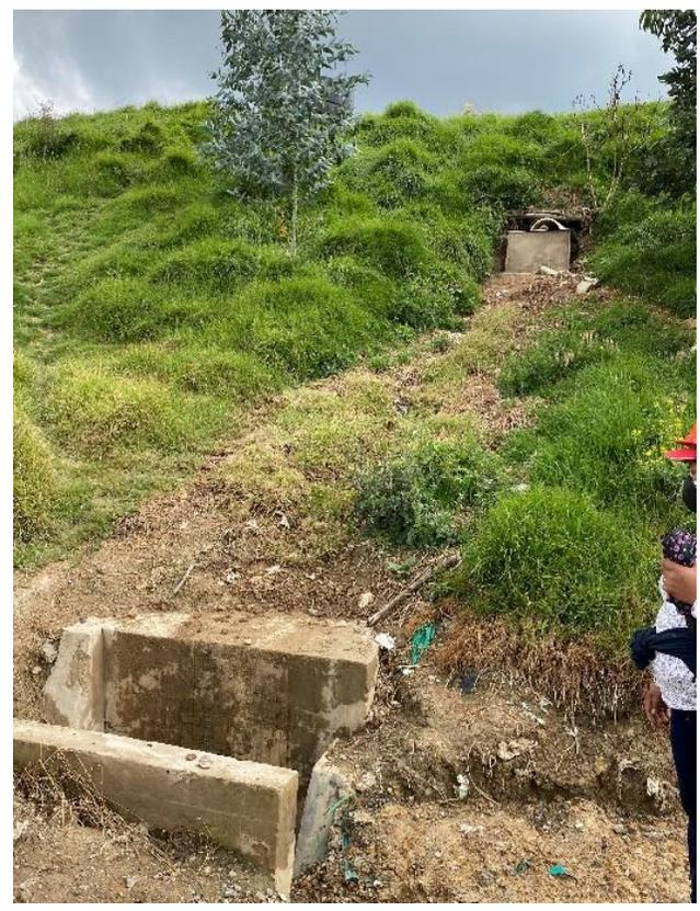
Fotografía 13. Retiro de teja de zinc, adecuación de tubería de drenaje de lixiviados y conexión a caja de inspección de lixiviados. Fuente: MVCT 10-03-2023
