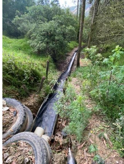
Fotografía 15. Evidencia del retiro de la tubería de impulsión de lixiviados. Fuente: MVCT 10-03-2023
