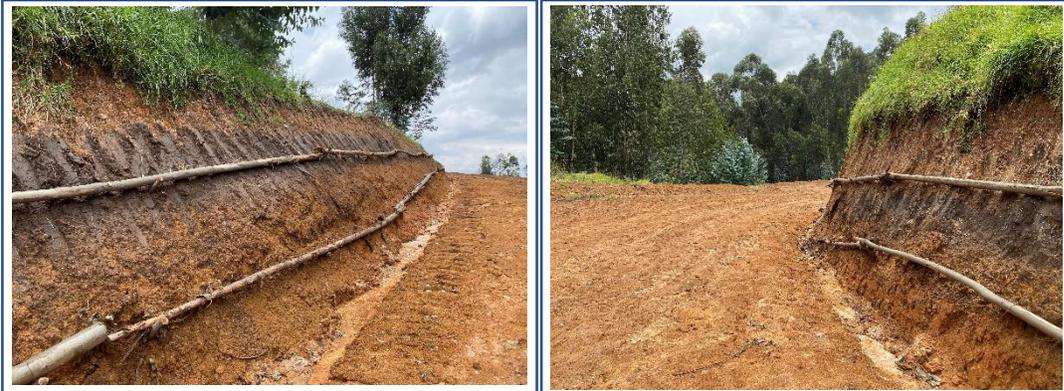
Fotografías 5 y 6. Proceso de empedricación en talud de corte de vía de acceso al pondaje No. 1. Fuente: MVCT 10-03-2023.
