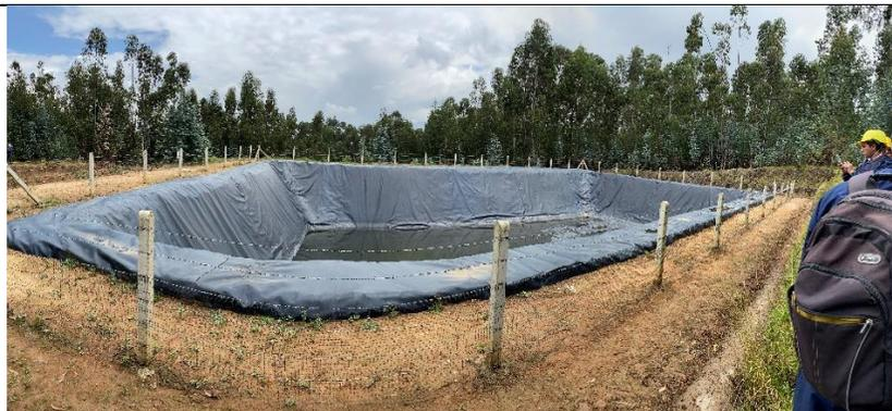
Fotografía 3. Pondaje para almacenamiento de lixiviado tratado, con capacidad de 2000 m<sup>3</sup>. Fuente: MVCT 10-03-2023
