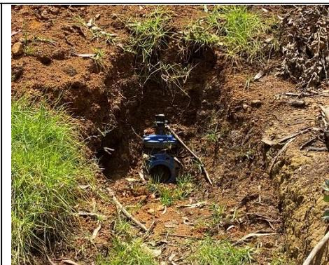
Fotografía 4. Válvula para salida de agua del pondaje No. 1 en caso de desagüe o mantenimiento. Fuente: MVCT 10-03-2023
