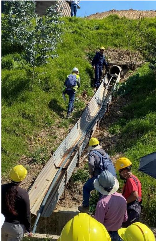
Fotografía 12. Tubería de drenaje de lixiviados sobre teja de zinc.
