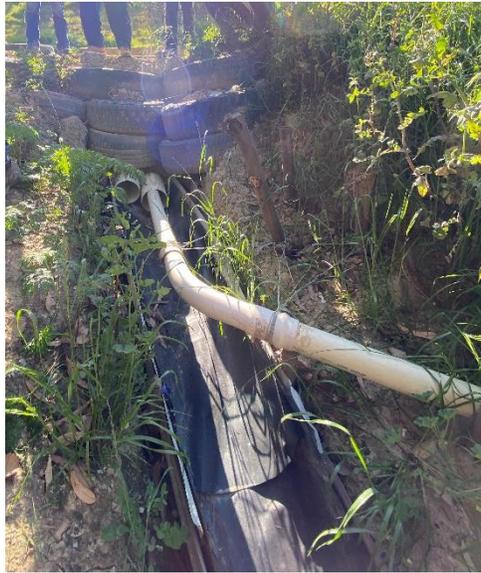
Fotografía 14. Tubería de impulsión de lixiviados con codo de 45°.
