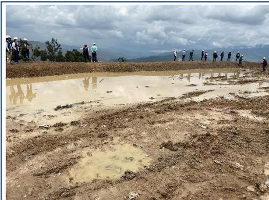
Fotografía 11. Al fondo de evidencia la adecuación de dique con material de recebo. Empozamiento de agua lluvia que se encuentra mezclada con lixiviado y gas que ha salido a la superficie. Fuente: MVCT 10-03-2023.
