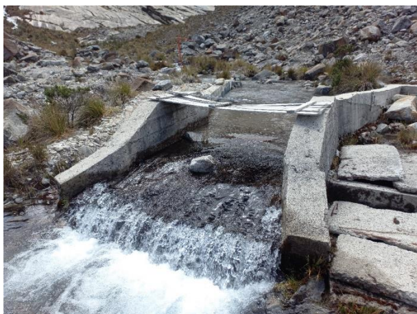
Ilustración 4. Captación Acueducto Tabor.
