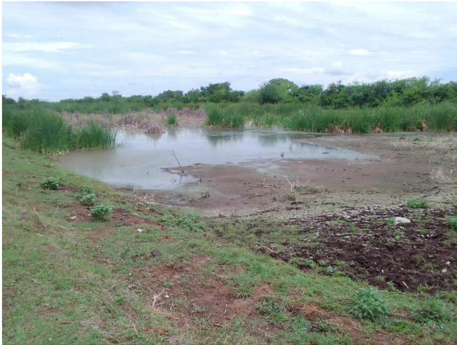
Vista general del estado del área en el que se localiza el sistema de tratamiento actual, el cual muestra poco mantenimiento y malas condiciones de operación y funcionamiento hidráulico. En este mismo lote de terreno de propiedad del municipio se implanta el sistema de tratamiento proyectado. El terreno carece de topografía por lo que deberá ser ajustado por la entidad formuladora.
