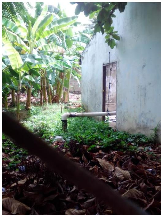
Estación de bombeo actual que data del año 2003. Se evidencia la falta de operación y estado avanzado de deterioro estructural. Esta estación de bombeo saldrá de funcionamiento. Un sistema similar se proyecta para otro sector de la red, dado que las condiciones del terreno demandan que deban ser elevadas las aguas residuales hasta el sistema de tratamiento proyectado.
