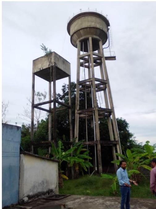
Área en el que se localiza un tanque de almacenamiento superficial y un tanque elevado de distribución, los cuáles serán optimizados con el proyecto para mejorar sus condiciones estructurales y funcionamiento hidráulico. En este lote de terreno se localizará la PTAP. El tanque elevado de la izquierda será demolido.
