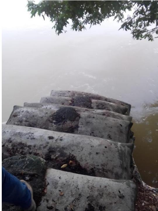
Escalinata existente al punto exacto definido para la captación, la cual consistirá en una barcaza flotante que tomará el agua del río Sinú y será impulsada hasta la PTAP que se construirá en la zona de tanques, a la salida del casco urbano.
