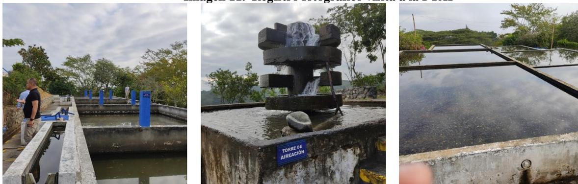
El estado de las estructuras descritas es bueno, en términos generales, se evidencian algunas fisuras en la zona de filtros, sin comprometer la operación de los componentes.
