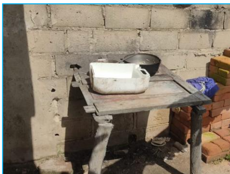
Ausencia de lavaplatos
