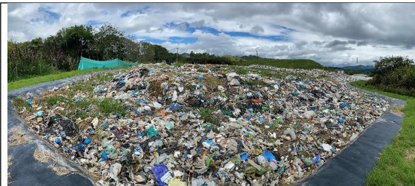
**Fotografía 5.** Celda actual de disposición final de residuos sólidos en el relleno sanitario de Pitalito. Visita MVCT Julio 18 de 2023
