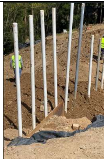
Fotografía 9. Obra de estabilización de talud con pilotes metálicos, lámina de acero y relleno con material en piedra, recebo y base granular. Fuente MVCT Visita 17-8-2023
