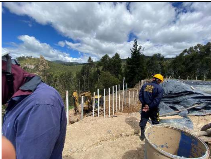
Fotografía 8. Obra de estabilización de talud con pilotes metálicos, lámina de acero y relleno con material en piedra, recebo y base granular. Fuente MVCT Visita 17-8-2023
