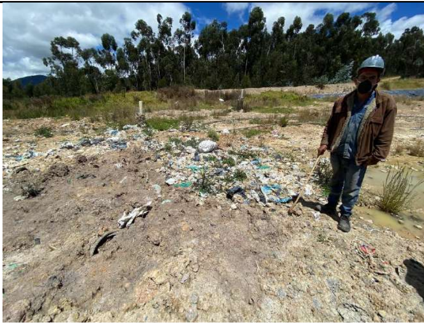
Fotografía 3. Disposición reciente de residuos sólidos en la parte alta del relleno sanitario. Fuente MVCT Visita 17-8-2023
