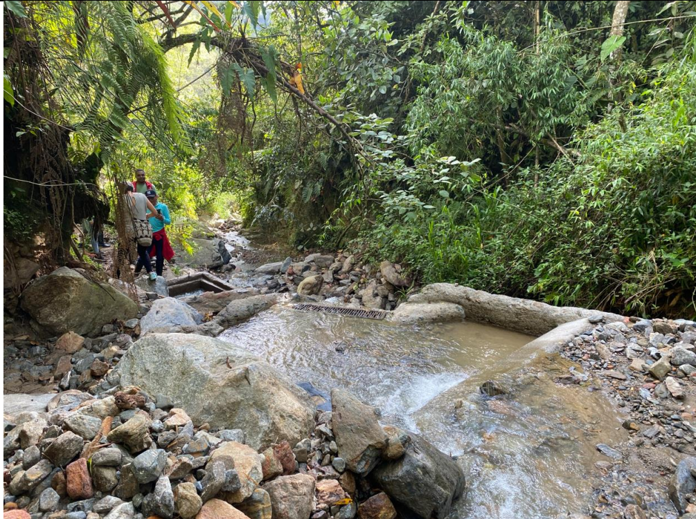
Bocatoma alterna quebrada Trinidad Latitud 7° 6'25.66"N longitud 75°33'26.72"O Fuente: MVCT- VASB-DPR
