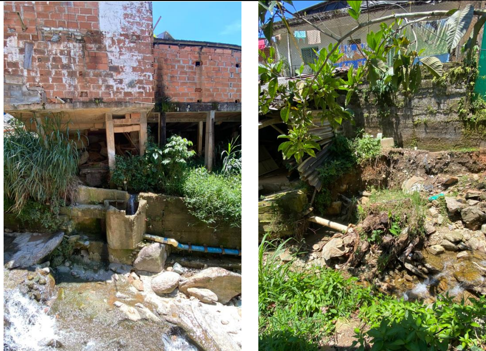
Redes mixtas de alcantarillado Fuente: MVCT- VASB-DPR
