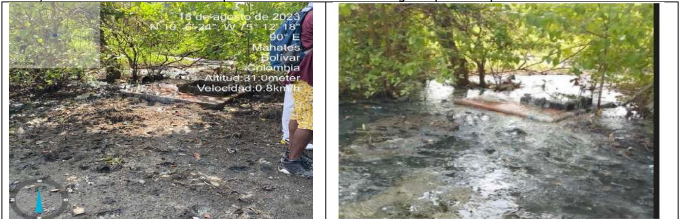
Fotografía No. 4 - Estado del Manjol a la llegada de planta - 18-08-23 (día de la visita MVCT).
