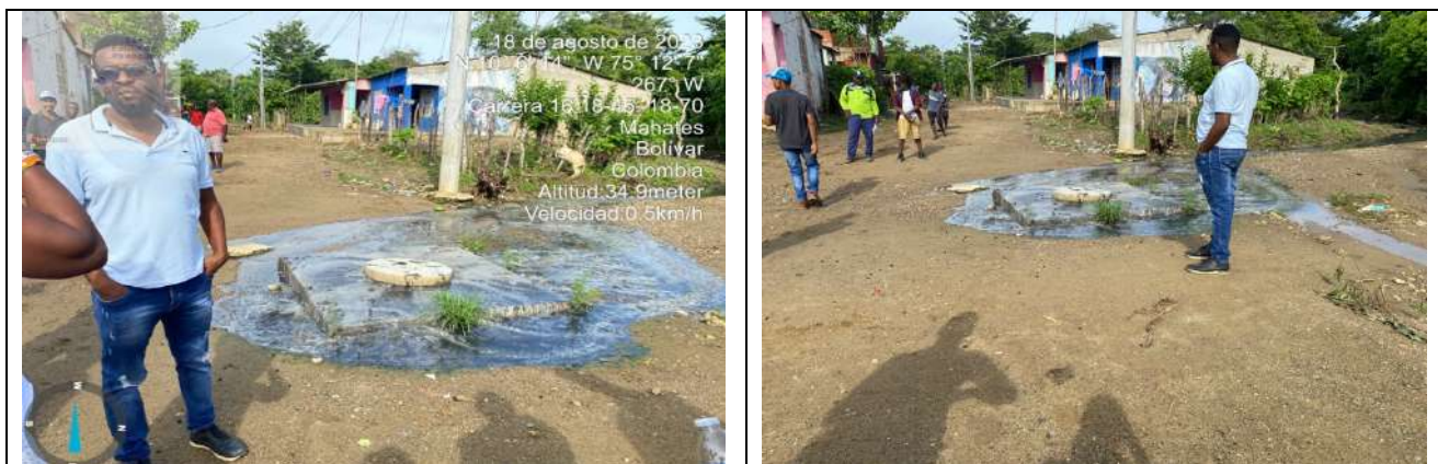
Fotografía No. 1- Reboce de sistema de alcantarillado – Manhol barrio Chopacho
