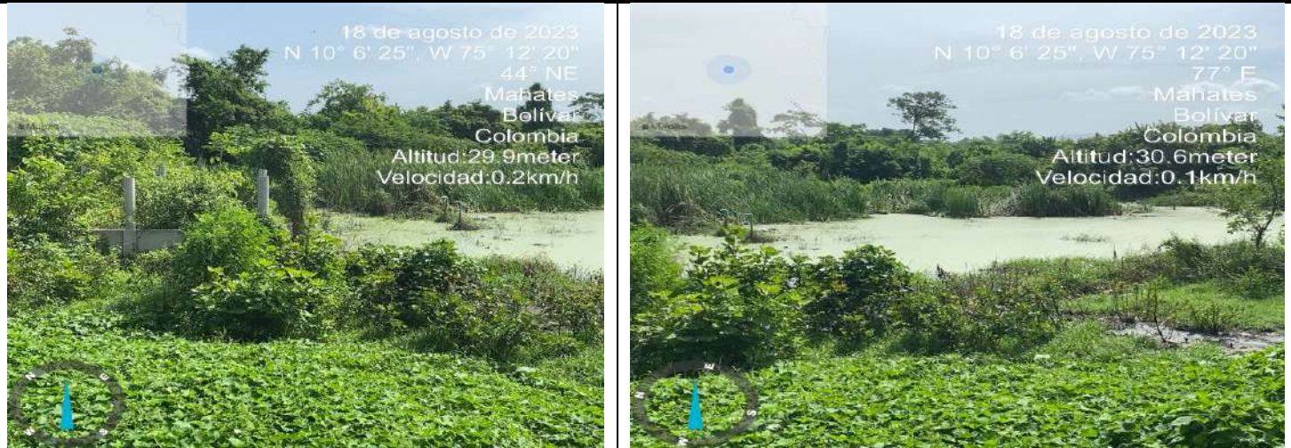
Fotografía No. 6 - Predio de PTAR inundado.
