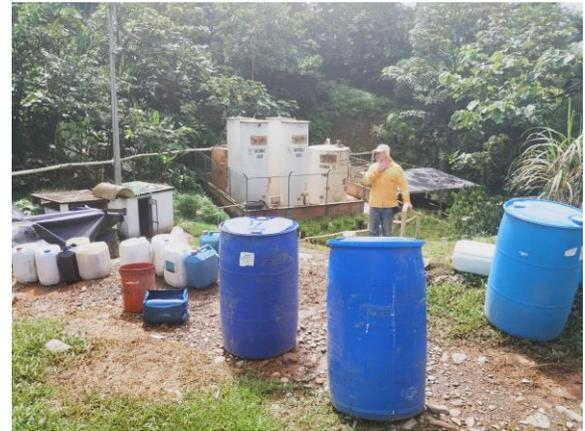
Imagen 16 – PTL, se muestran los tanques de tratamiento biológico anaerobio (UASB) y el tanque de tratamiento aerobio tipo MBBR.
