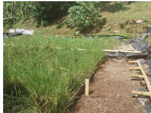
Imagen 14 – PTL. Humedales artificiales de flujo horizontal subsuperficial.
