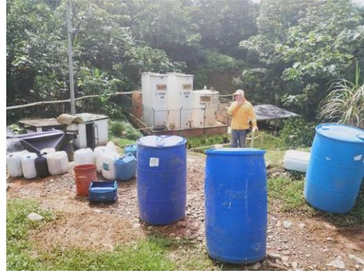
Imagen 12 – Córdoba. Al fondo PTL, se muestran los tanques de tratamiento biológico anaerobio (UASB) y el tanque de tratamiento aerobio (MBBR).
