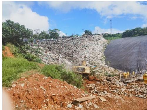
Imagen 8 - Córdoba. Izquierda, ampliación del vaso 1 con residuos expuestos.
