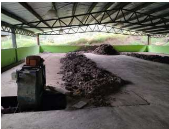
Fotografía 9. Pilas conformadas en suelo falso para inyección de aire
