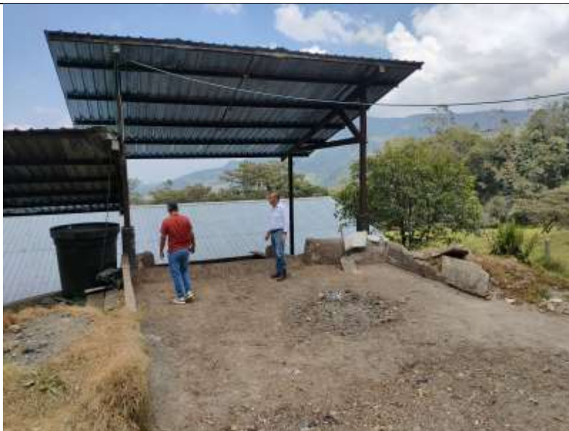
Fotografía 3. Zona de descargue
