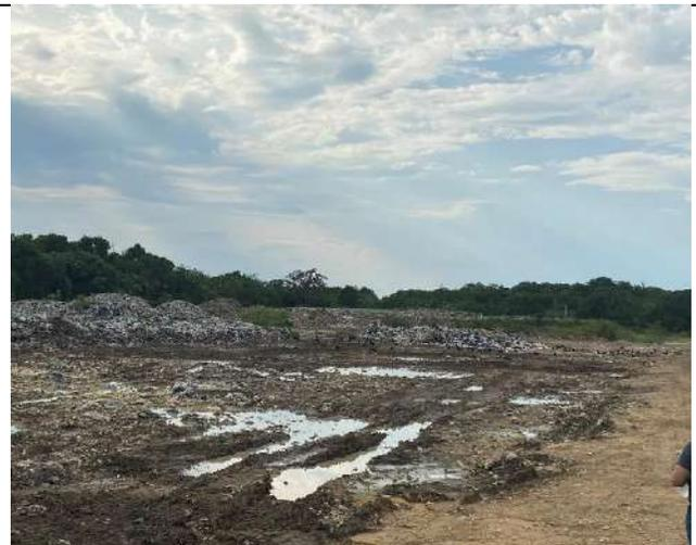
**Fotografía 2.** Relleno sanitario "El Colibrí", proceso de acomodación de material dentro de la celda de disposición final. Fuente MVCT 19-10-2023
