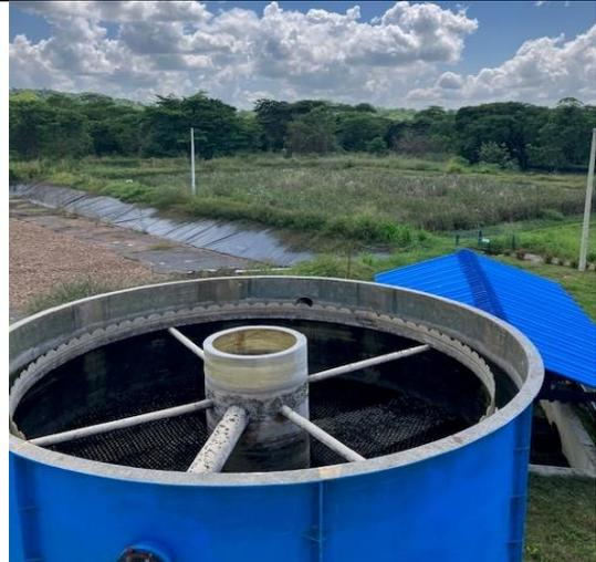
Explicación del funcionamiento del modulo UASB, lechos de secado y laguna. El operario no sabe que hacer en caso de falla del sistema, se solicitó al contratista elaborar check list y socializar nuevamente el manual de operación, y mantenimiento, así como los formatos a diligenciarse.
