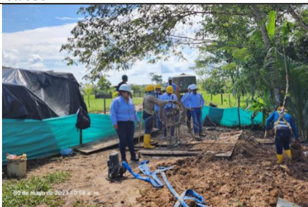
Construcción de caisson
