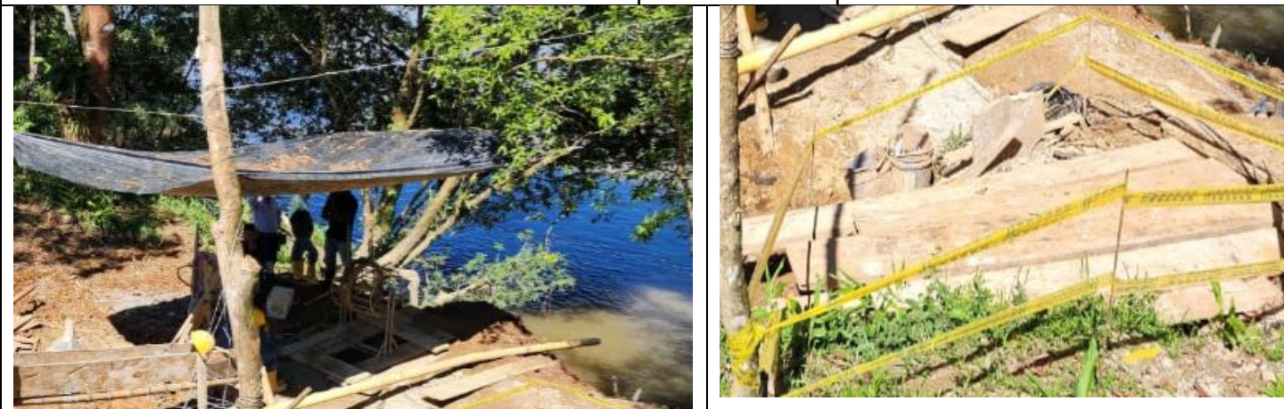
Frente de obra plataforma de Captación
